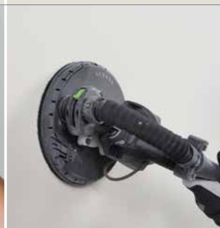
Šlifavimas mechanizuotu būdu
