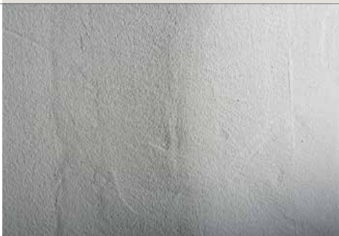
Iškilusi glaistyta siūlė, esant stipriam šoniniam apšvietimui.
