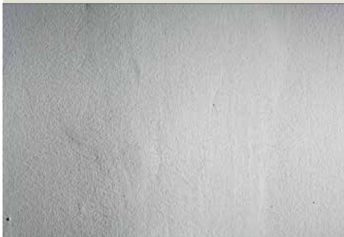
Iškilusi glaistyta siūlė, esant silpnam šoniniam apšvietimui.
