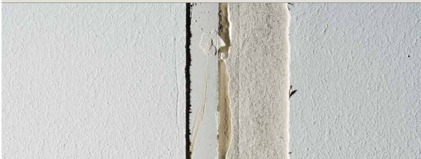
Priežastis – per mažai glaisto po armavimo juosta SK briaunos pusėje (į kairę nuo siūlės centro).
