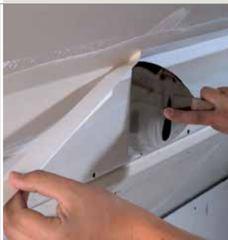
Tinkamas siūlių glaistymas, naudojant Kurt armavimo juostą mansardoje.
