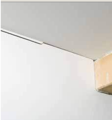
Nelygus trūkis, susidaręs dėl neatskirtų konstrukcijų.
