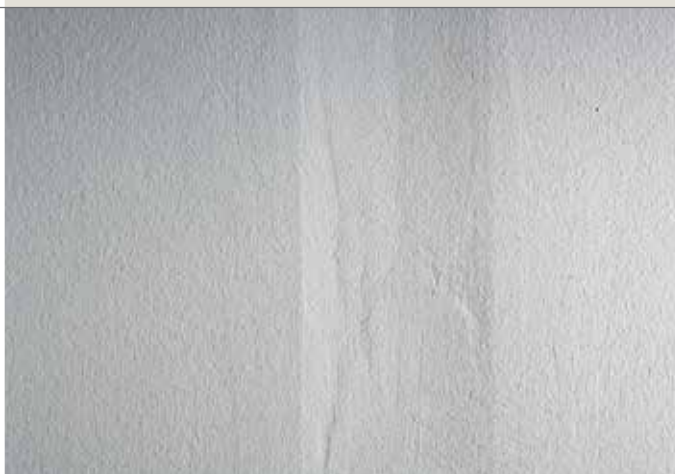
Iškilusi glaistyta siūlė, esant stipriam šoniniam apšvietimui.
